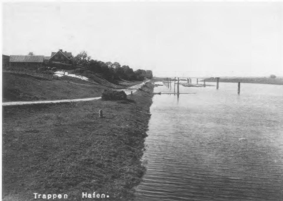
**Der Hafen:** Trappönen besaß einen vorbildlich ausgebauten Hafen. Er wurde in den Jahren 1904/05 gebaut. Die Länge des Hafens wurde mit 500 Meter, die Breite mit 120 Meter angegeben. Die Ankerplätze für Boydaks und sonstige Flußschiffe wurden im Winter als Ruheplätze genutzt. Durch den erhöhten Damm waren die Schiffe vor dem starken Eisgang der Memel gesichert.
