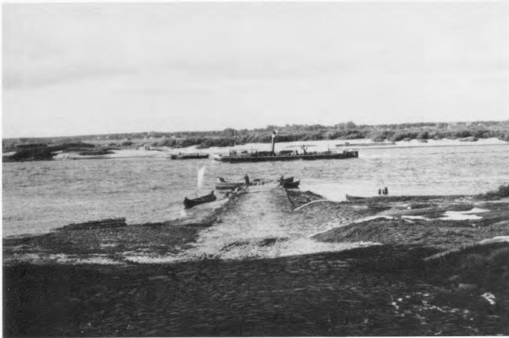
**Die Fähranlegestelle:** Die Verlängerung der Zollstraße mit befestigtem Damm wurde zugleich als Fähranlegestelle genutzt. Die Fähre diente der Stromüberquerung. Entlang eines Seiles, welches an den Ufern befestigt war, wurde die Fähre durch die Wasserströmung angetrieben.
