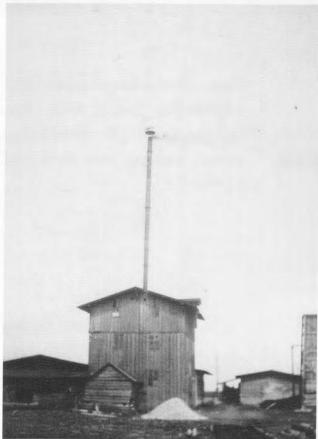
**Heizwerk:** Das Sägewerk des David Gerull in Trappönen. In dem höheren Teil des Gebäudes befinden sich das Heizwerk für die Herstellung von Dampfkraft zum Betrieb der Gatter (Sägen) und die Mühle.
